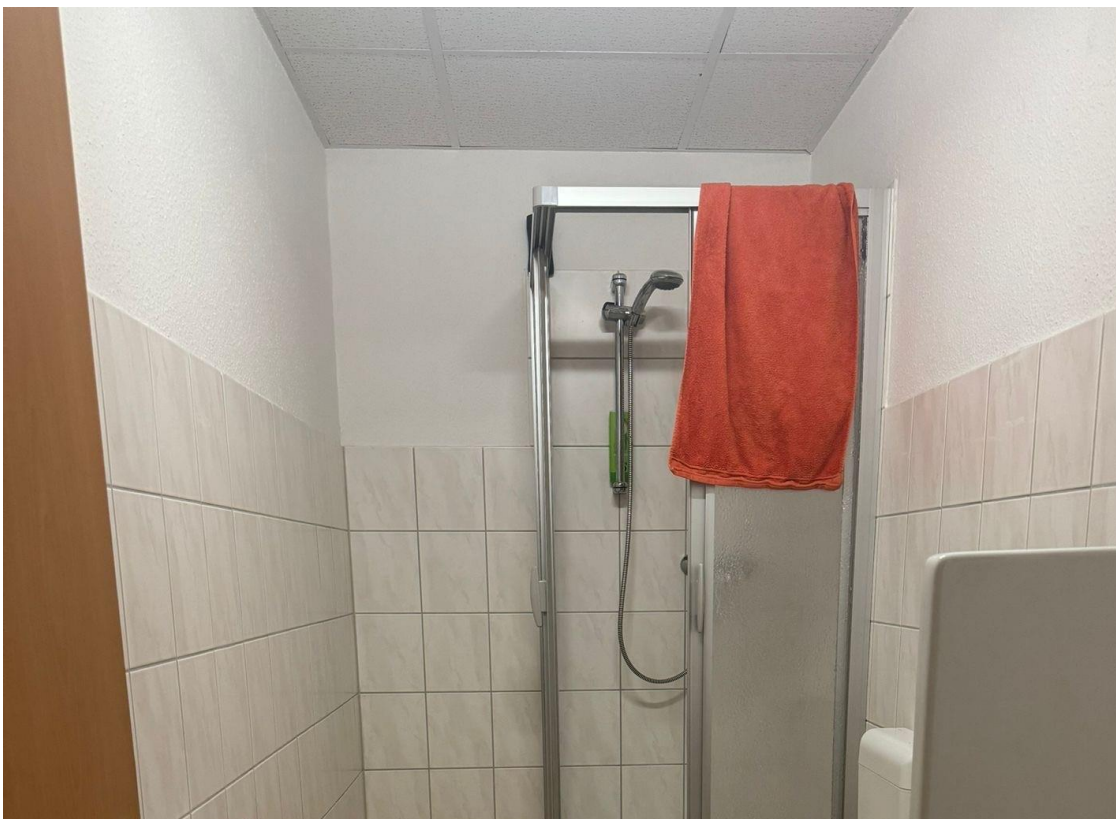
Abb. 3: Ein WC-Raum ist mit einer Duschköglichkeit ausgestattet.
