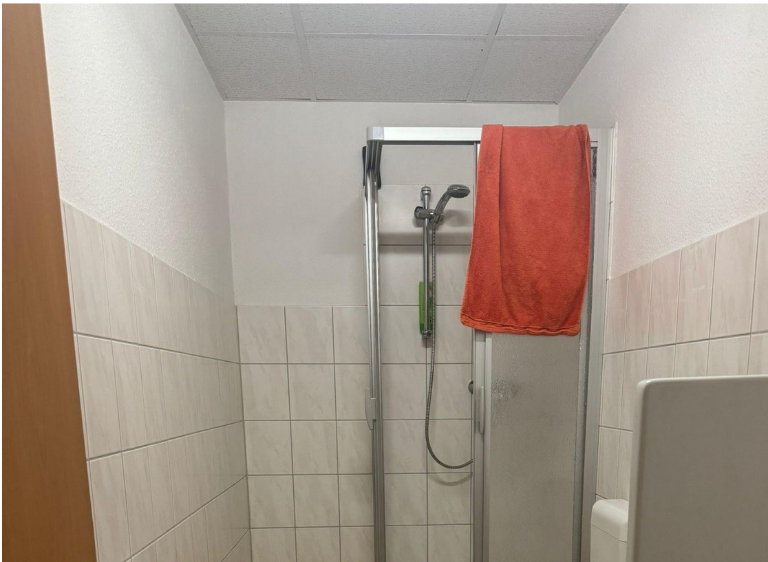
Abb. 3: Ein WC-Raum ist mit einer Duschköglichkeit ausgestattet.
